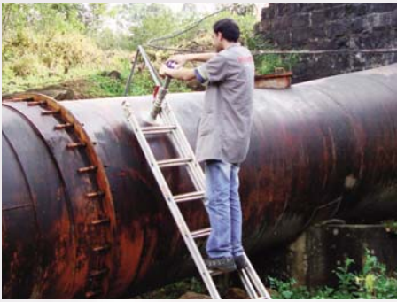
VMI em tubulação de 2 metros de diâmetro em usina hidrelétrica
